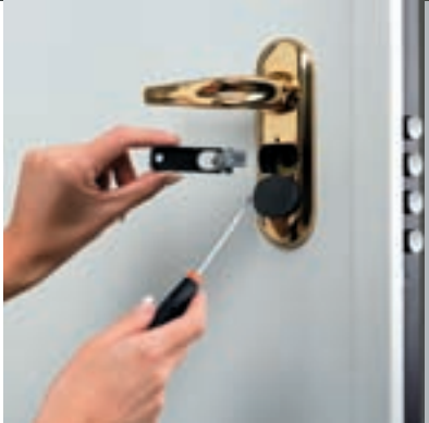
CON UN CACCIAVITE SVITARE LE DUE VITI CHE FISSANO IL BLOCCHETTO
