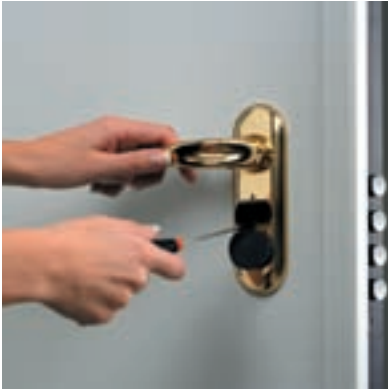
CON UN CACCIAVITE SVITARE LE DUE VITI CHE FISSANO IL BLOCCHETTO
